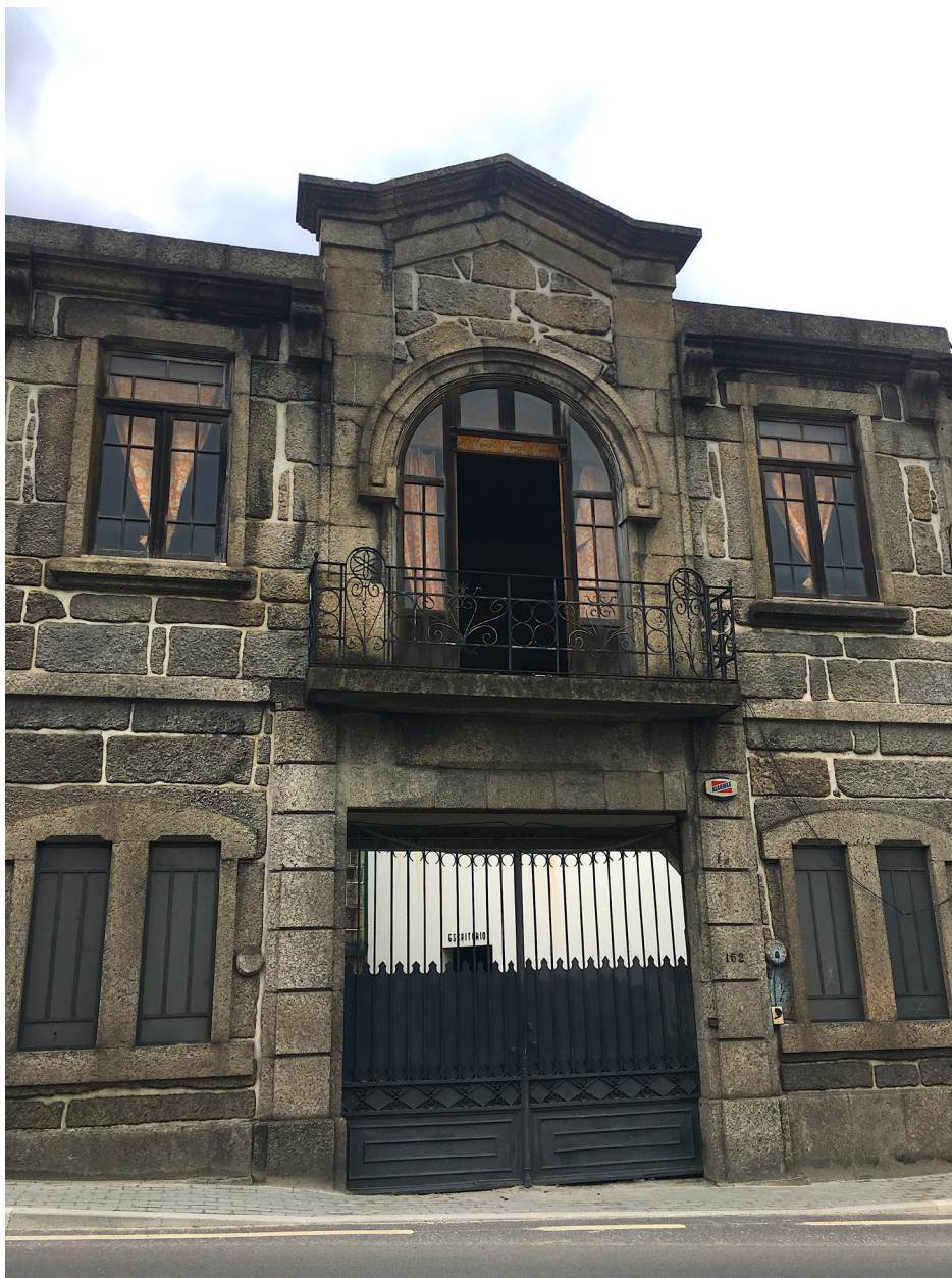
Fachada principal e entrada da Fábrica do Castanheiro (1885-2013).
